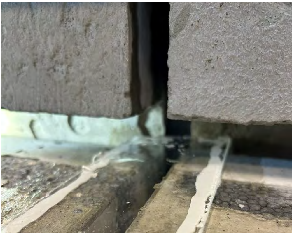
2C. Pågående provning (SS-EN 12865:2001). Vatten från L2. Vattnet vandrade mot insidan av den yttre betongskivan, i den vertikala fogen, se även bild 2 och 2B.
