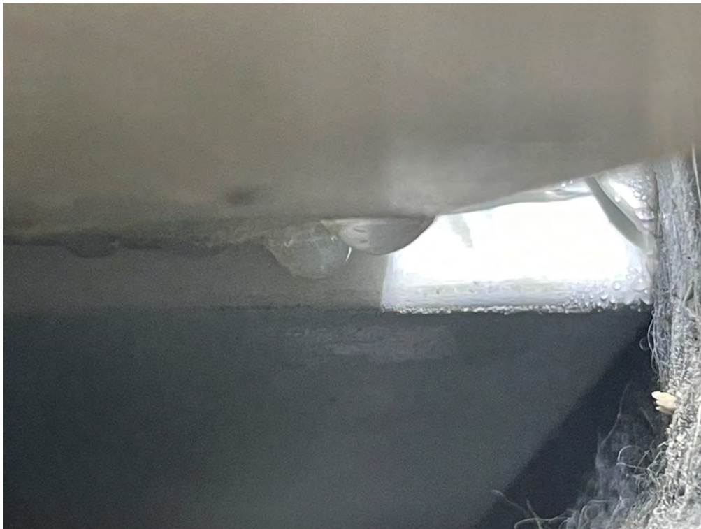
8. Notering 3 (N3) vid steg 3, 0-150 Pa. Dropp in på sekundärtätning innanför underbleck.
