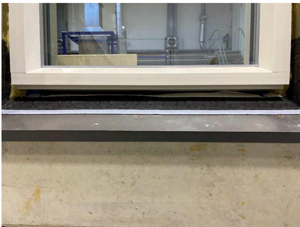
23. Under uppbyggnad innan provning. Montage av fönster med tätningar.
