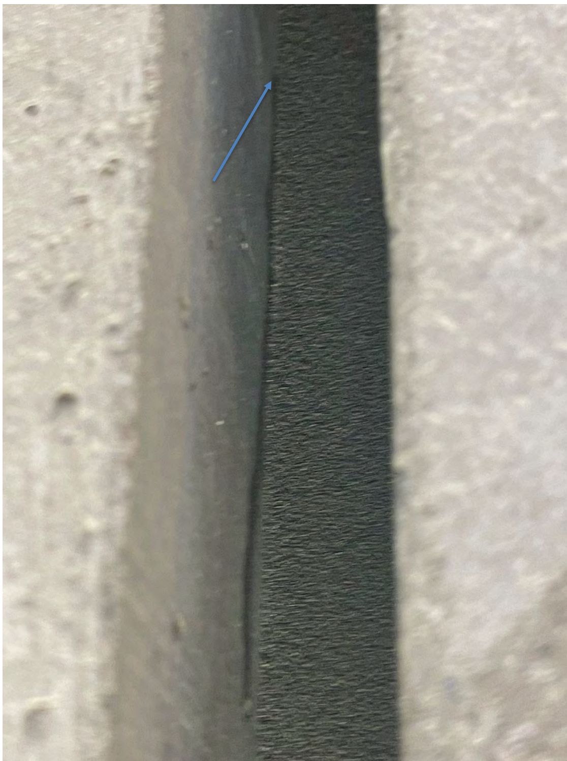
9. Pågående provning (SS-EN 12865:2001) L9. Vertikalfog med fogband. Se blå pil. Vid 0-150Pa, Steg 3.
