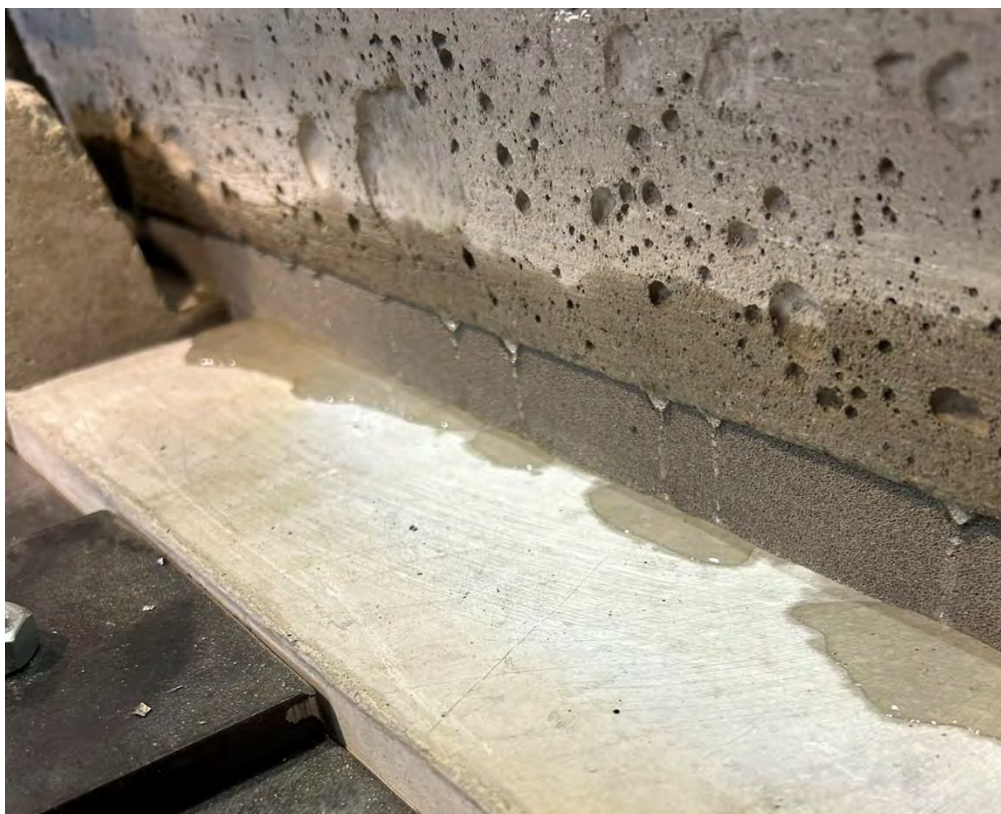
11B. Pågående provning (SS-EN 12865:2001) L11 Ovensida balkong. Ovensida fogband. Vid 0-300 Pa, Steg 6.
