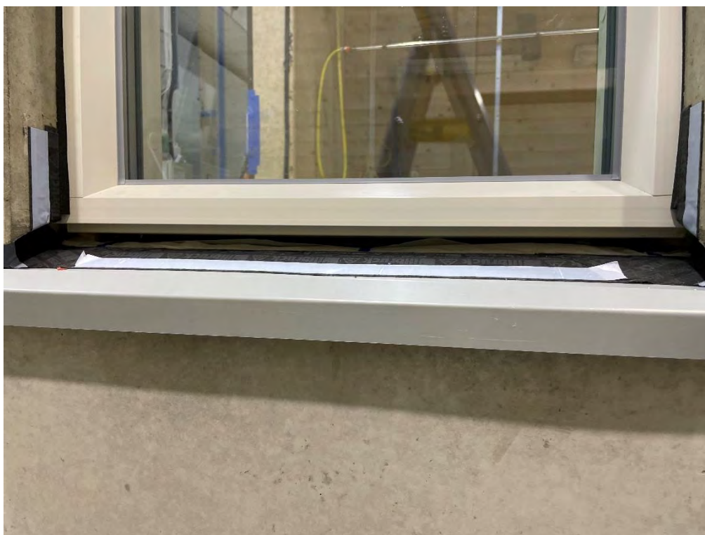
22. Under uppbyggnad innan provning. Montage av fönster med tätningar.
