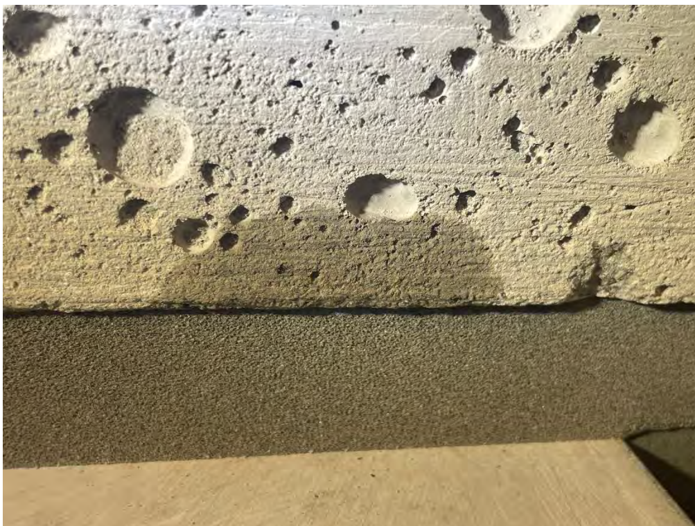
4. Pågående provning (SS-EN 12865:2001) L4. Ovankant balkong, ovkant fogband. Vid 0-75Pa, Steg 2.
