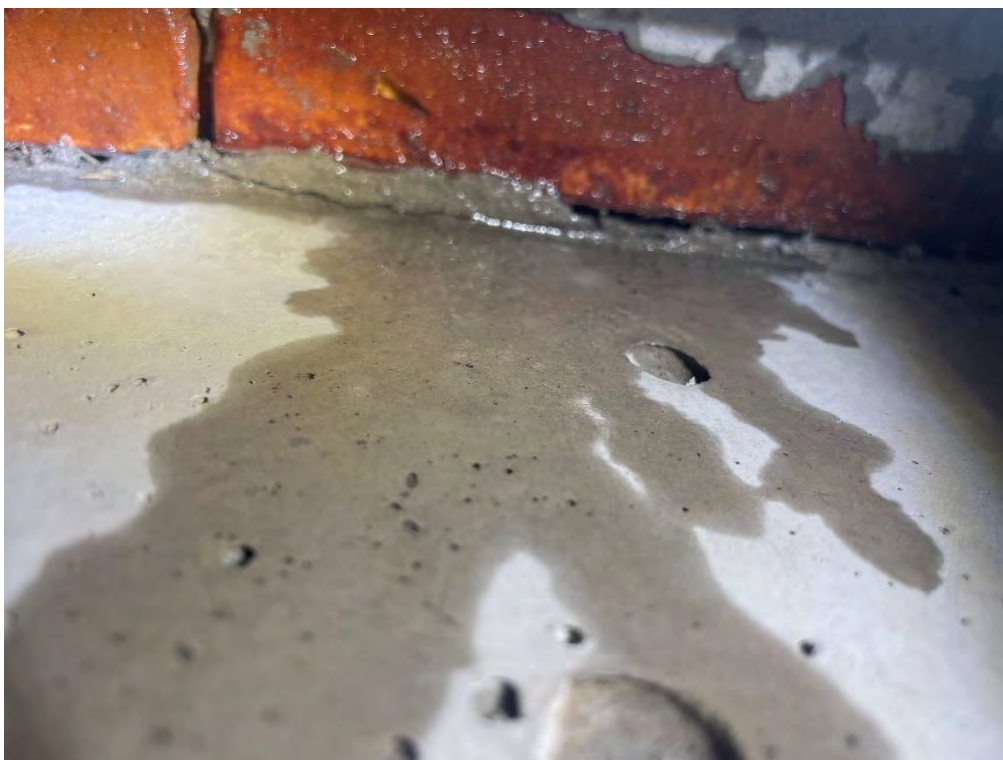
15. Pågående provning (SS-EN 12865:2001) L18. Mellan den yttre betongskivan och isoleringen under fönstret. Vid 0-300Pa, Steg 6.
