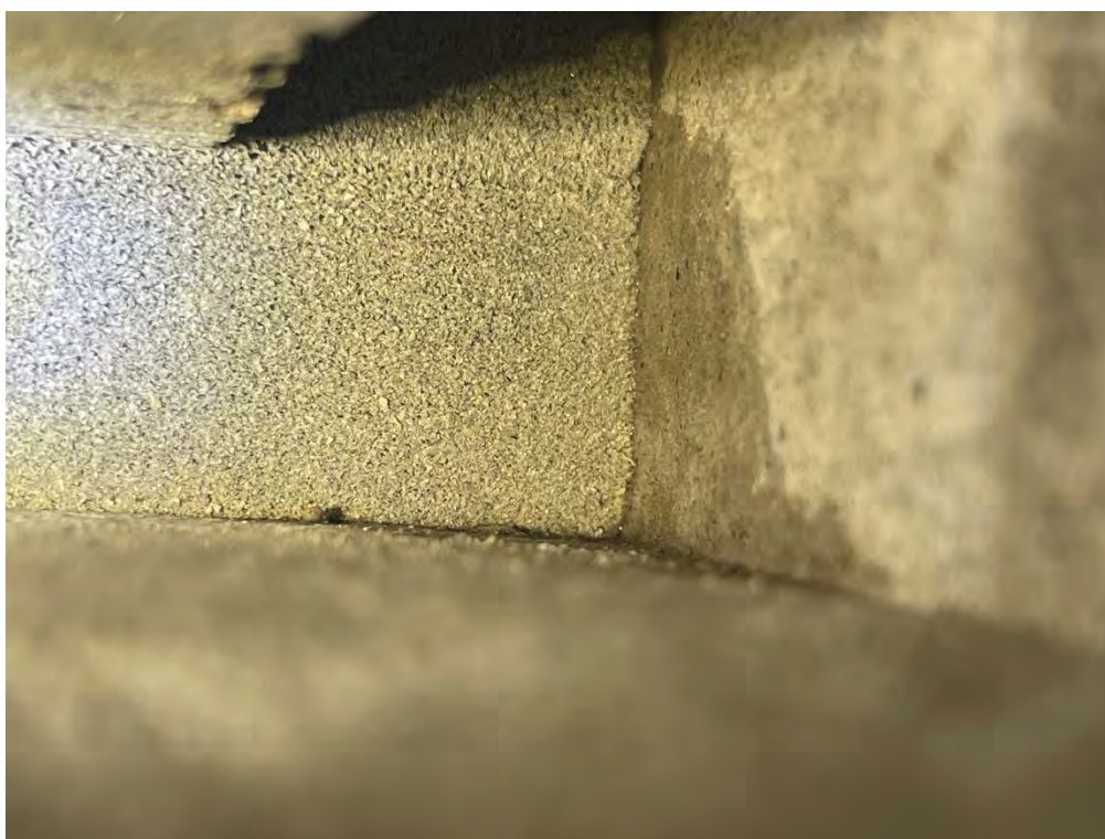
12. Pågående provning (SS-EN 12865:2001) L12. Underkant balkong (höger). Fogbandets mot elementsida hörn. Vid 0-150Pa, Steg 3.
