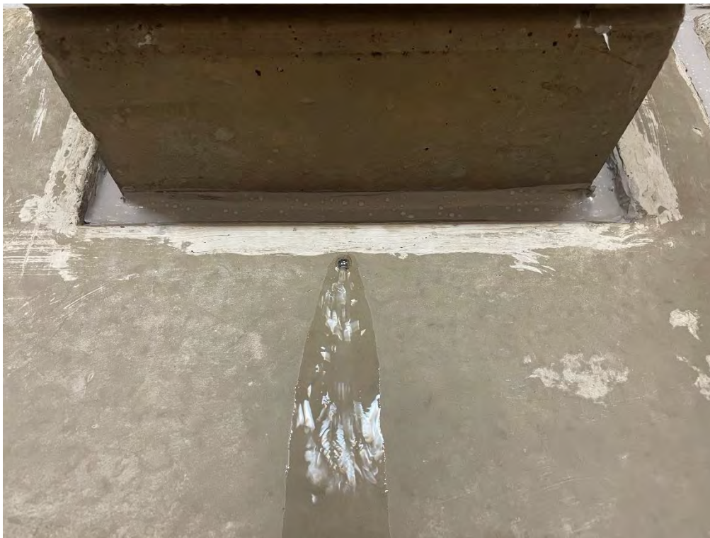
9. Indikativ funktionsprovning 1. Luftspaltens dräneringsförmåga mellan primär- och sekundärfogen provades genom att påföra vatten från insidan genom fogen i överkanten av balkongelementet.
