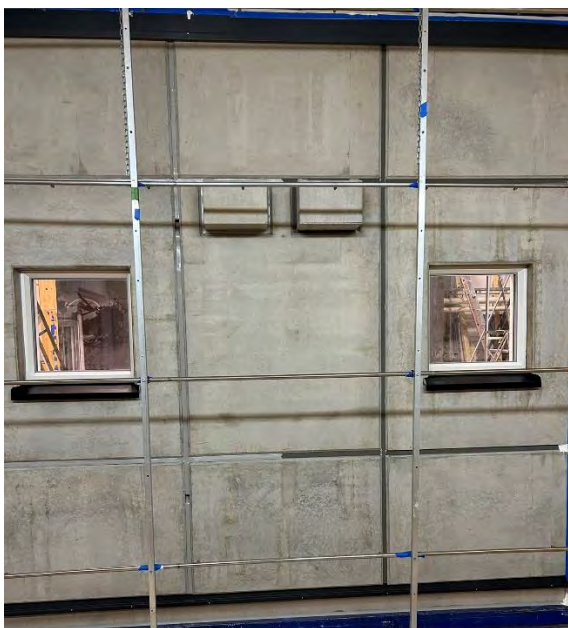
Figur 1. Fasad/framsida av testobjekt A (t.v. i bild) och D (t.h. i bild) monterade i slagregnskammare inför testomgång 2.
