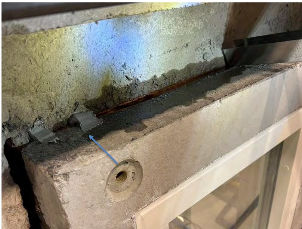
20A. Pågående provning (Indikationsprovning 3.) Isolering med plastlist ovanför fönster. Fogmassa har placerats för att valla in påfört vatten (se blå pil).
