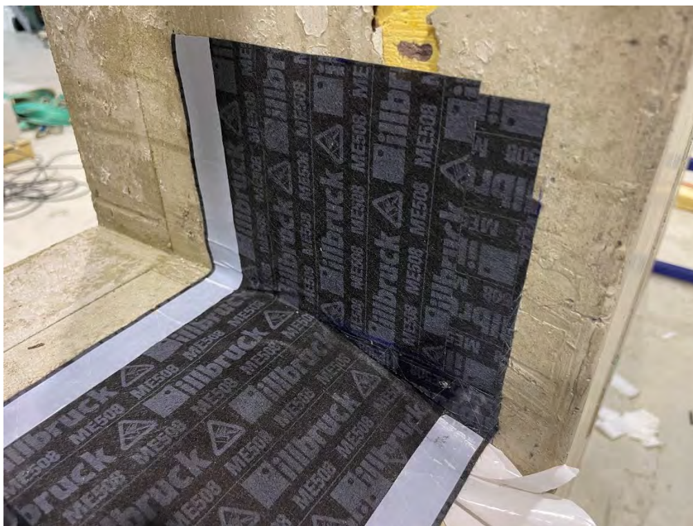
22. Under uppbyggnad innan provning. Sekundärtätning monteras i två överlappande skikt.
