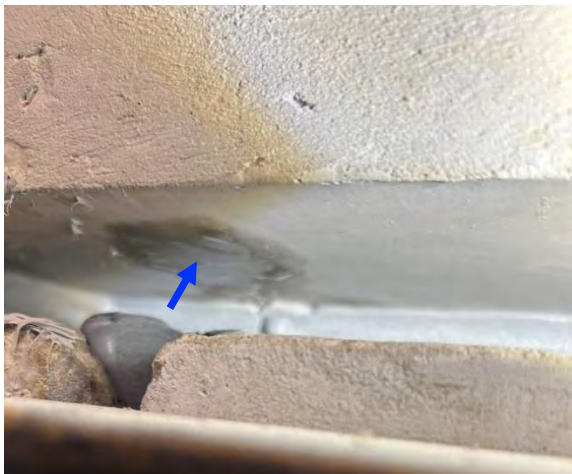
Figur 7. Skvätt från vattendroppar, se pil, ovanför TDV-öppning i horisontell elementskarv vid balkong.
