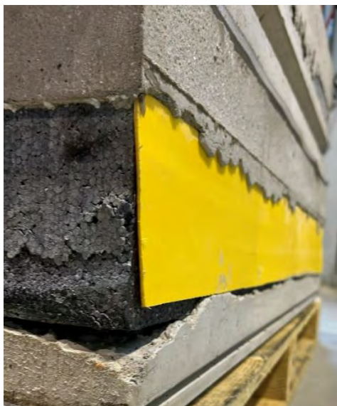
Figur 5. Vattenframledande plastlist i nederkant av betongsandwichelement. Elementet ligger ner på en lastpall.
