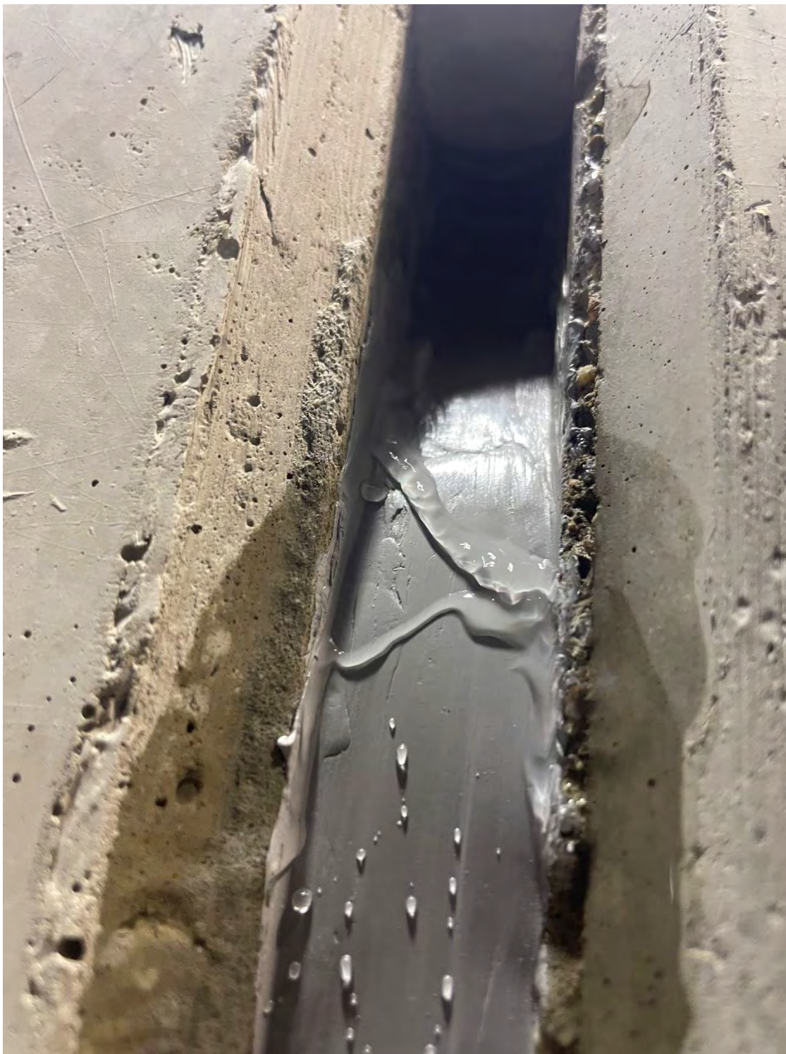
17. Pågående provning (indikeringsprovning 1.) Vattenflödet dränerar ut via TDV-öppning.
