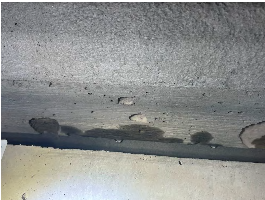
14. Pågående provning (SS-EN 12865:2001) L16. Horisontalfog. Ovankant fogband. Vid 0-300Pa, Steg 4.
