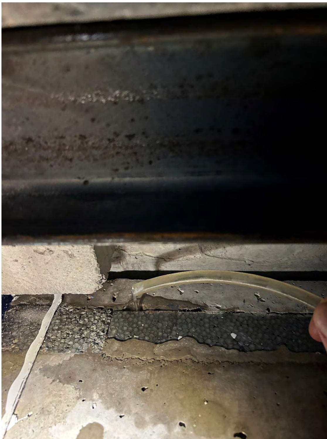
19A. Vid pågående provning (Indikationsprovning 2.) Indikerande funktionstest av dränageförmåga. Ett kontrollerat vattenflöde påförs i betongelementets överkant (ca 1 meter upp i vägg och ca 20 cm från elementhörn mellan ytterskiva och isoleringsskikt.
